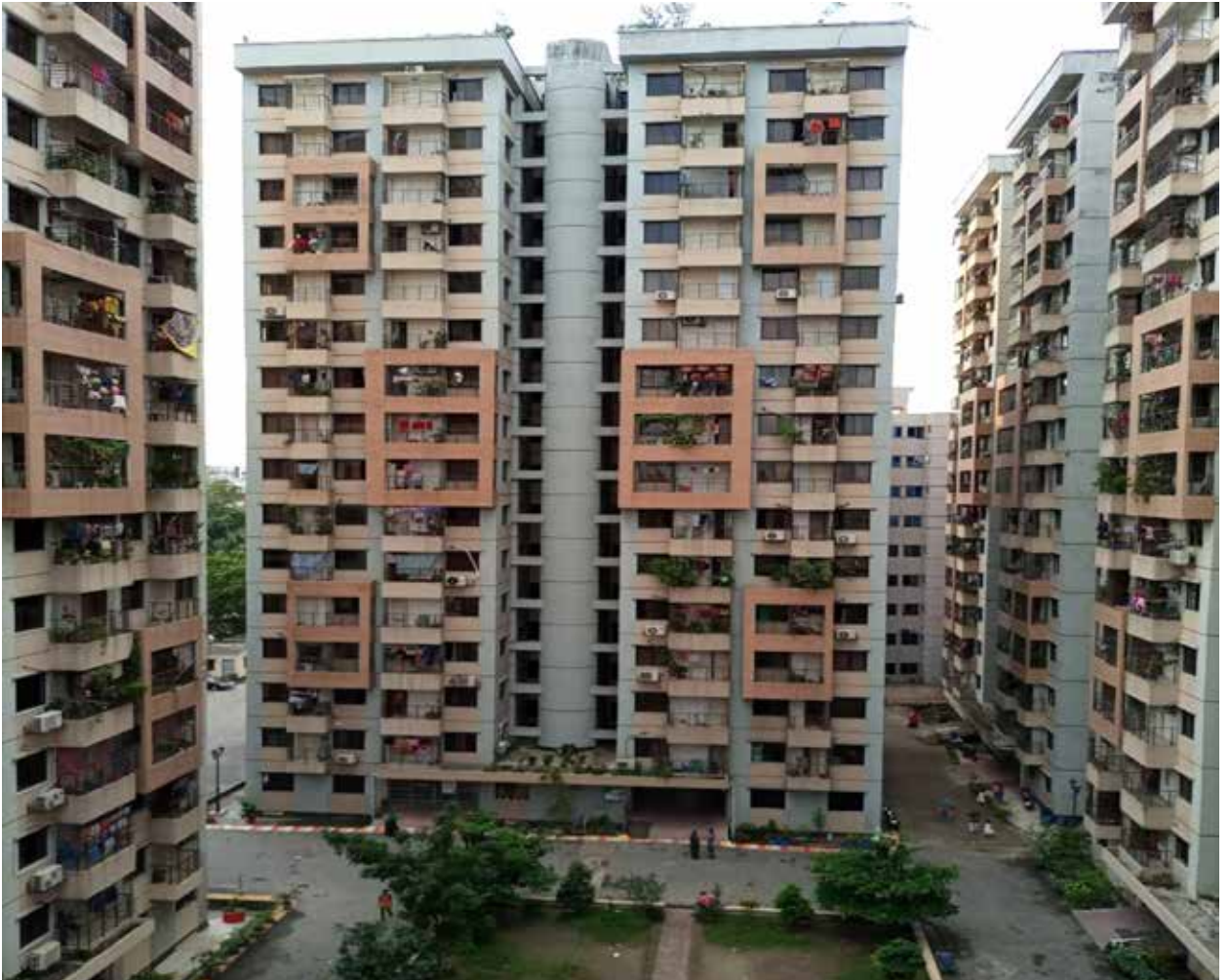
চিত্র: ঢাকার মিরপুরস্থ ২নং সেকশনের “আই” ব্ল-কে সরকারি কর্মকর্তাদের জন্য আবাসিক ফ্ল্যাট নির্মাণ প্রকল্প।
