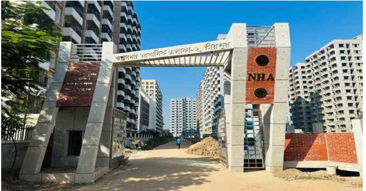
চিত্র: ঢাকার মিরপুরস্থ ৯ নং সেকশনে স্বল্প ও মধ্যম আয়ের লোকদের জন্য ১৫টি ১৪তলা বিশিষ্ট আবাসিক ফ্ল্যাট নির্মাণ (স্বপ্ননগর -২) প্রকল্প।
