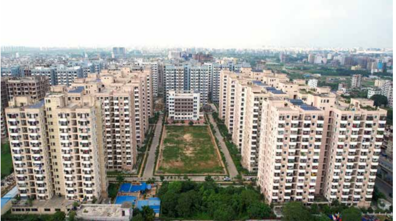
চিত্র: ঢাকার মিরপুরস্থ ৯ নং সেকশনে স্বল্প ও মধ্যম আয়ের লোকদের জন্য ১০ টি ১৪তলা বিশিষ্ট আবাসিক ফ্ল্যাট নির্মাণ (স্বপ্ননগর -১) প্রকল্প।
