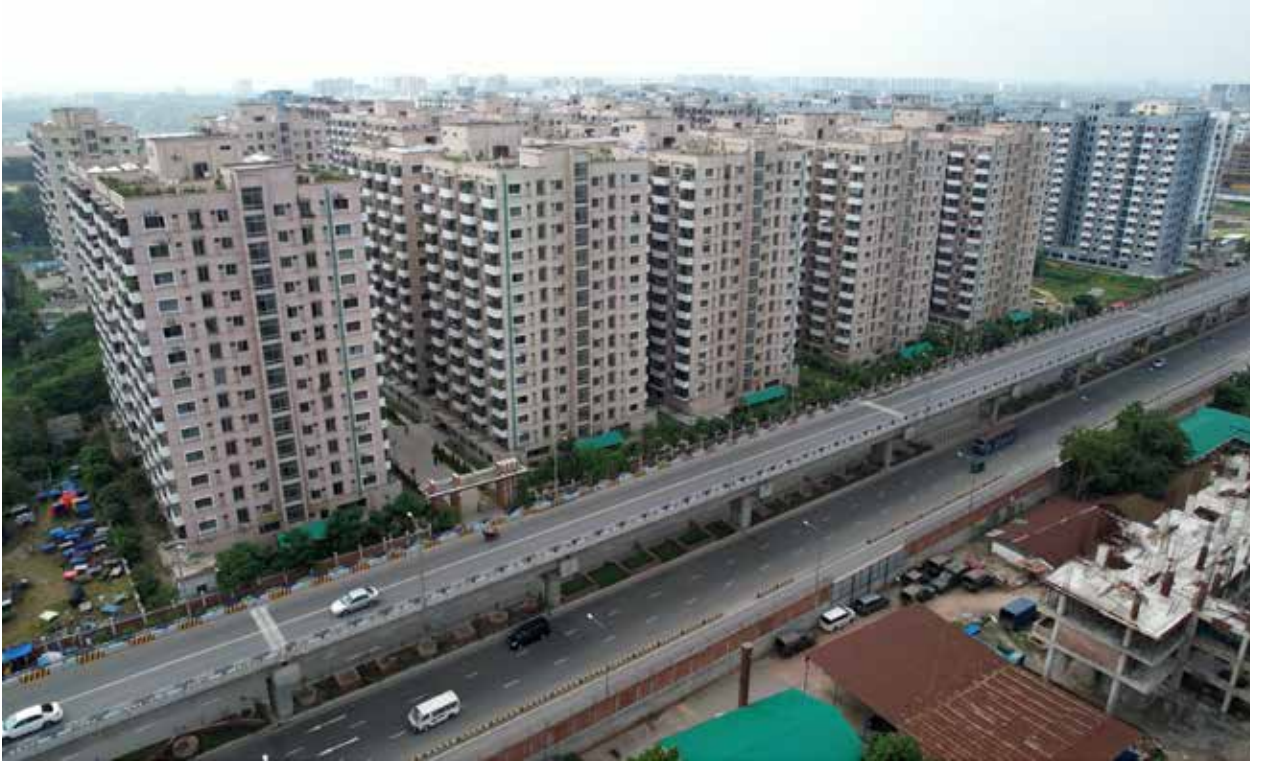
চিত্র: ঢাকার মিরপুরস্থ ৯ নং সেকশনে স্বল্প ও মধ্যম আয়ের লোকদের জন্য ১০টি ১৪তলা বিশিষ্ট আবাসিক ফ্ল্যাট নির্মাণ (স্বপ্ননগর -১) প্রকল্প।
