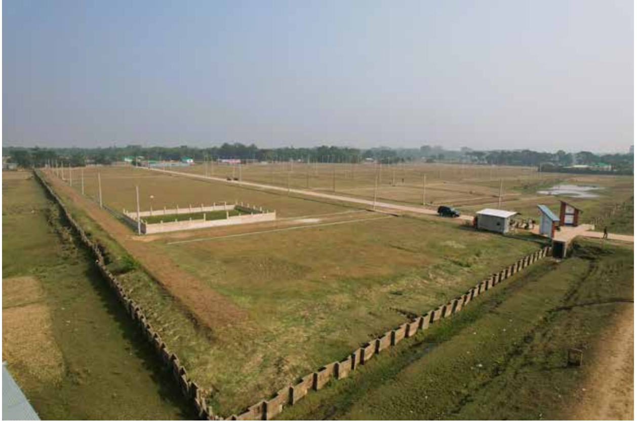
চিত্র: সুনামগঞ্জে সাইট এন্ড সার্ভিসেস আবাসিক প্লট উন্নয়ন প্রকল্প।
