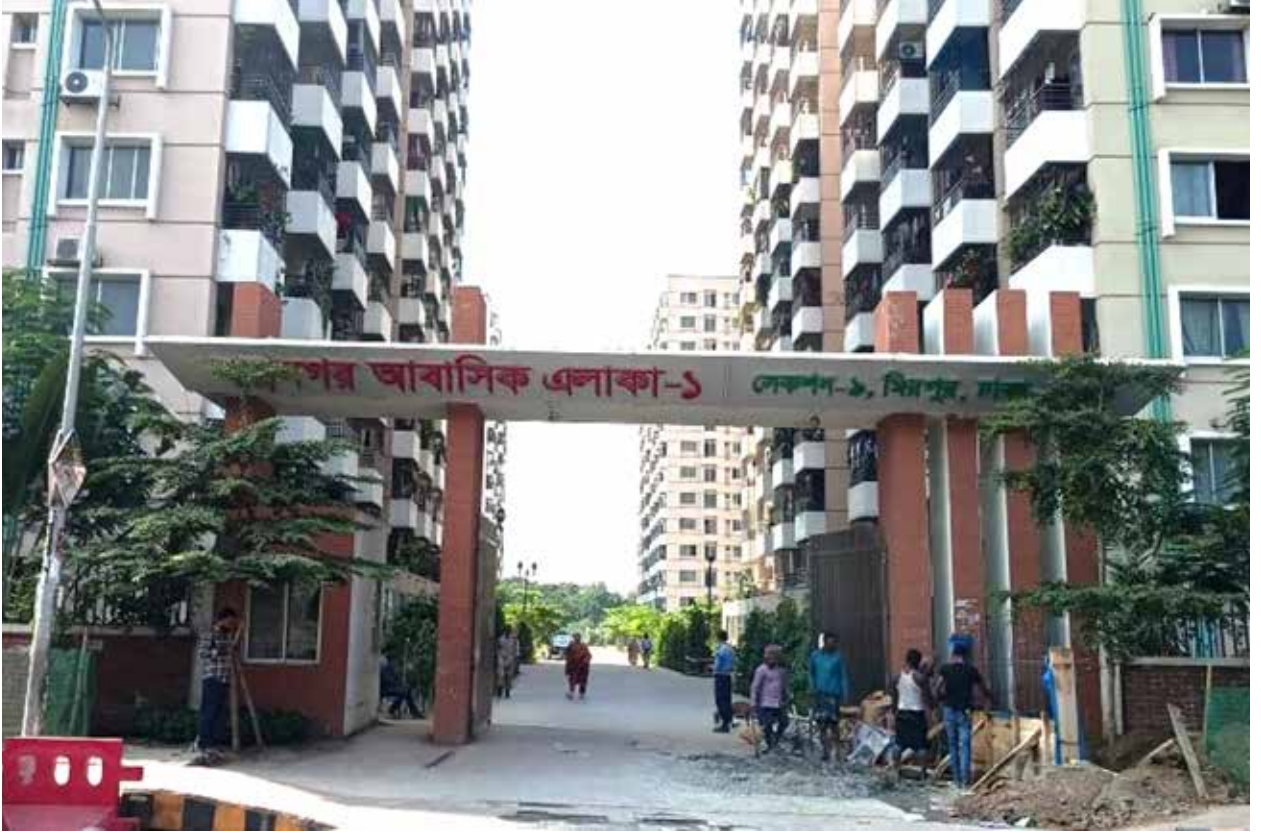
চিত্র: ঢাকার মিরপুরস্থ ৯ নং সেকশনে স্বপ্ননগর-১ আবাসিক ফ্ল্যাট নির্মাণ প্রকল্পের প্রবেশদ্বার
