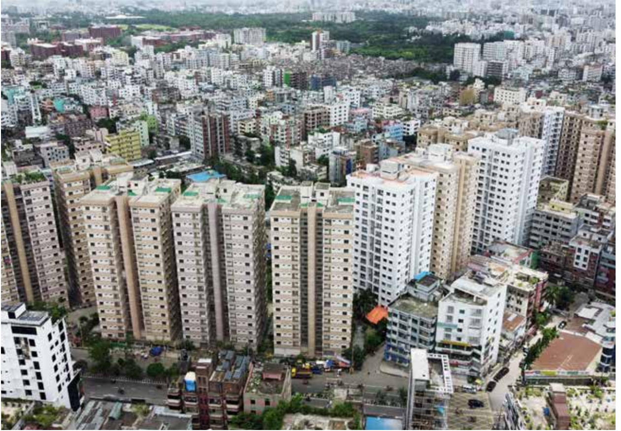
চিত্র: মোহাম্মদপুরস্থ “এফ” ব্লক-কের ১৬তলা বিশিষ্ট ১৫টি ভবনে আবাসিক ফ্ল্যাট নির্মাণ প্রকল্প। (সমাণ্ড)
